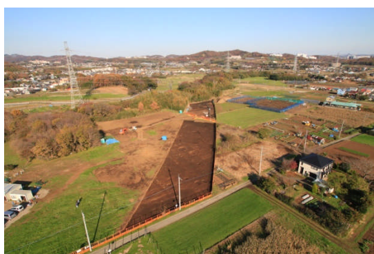
調査区全景ラジヘリ撮影（南西から）
