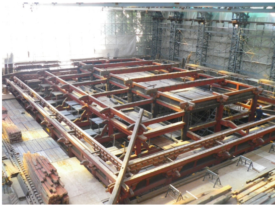
写真 124 宝城坊本堂平成の大修理
