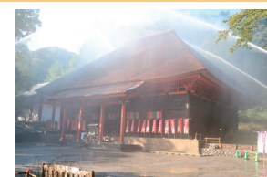
宝城坊防災施設整備
