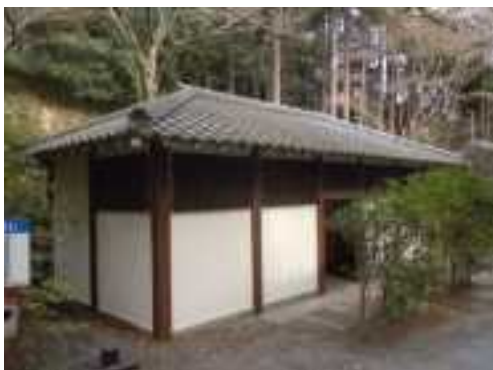
写真 135 改修した公衆トイレ
