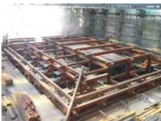
写真 124 宝城坊本堂平成の大修理
