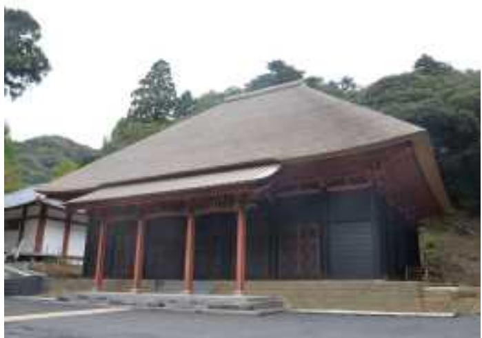
写真 44 宝城坊本堂 (平成 7 年 12 月 26 日指定) [所有者] 宝城坊 [時期] 万治 3 年 (1660、江戸時代前期) 建立、 延享 2 年 (1745、江戸時代中期) 改修
