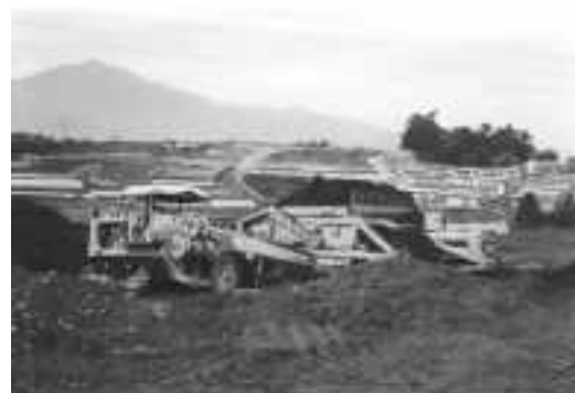
写真30 八幡台の造成(昭和30年代)
