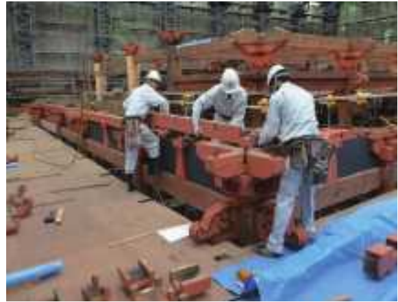
写真 101 宝城坊本堂の保存修理
