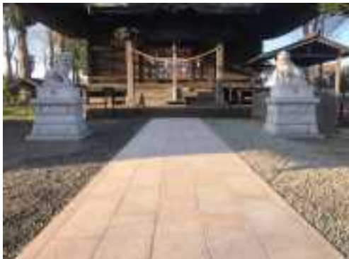
写真 133 高部屋神社参道の改修
