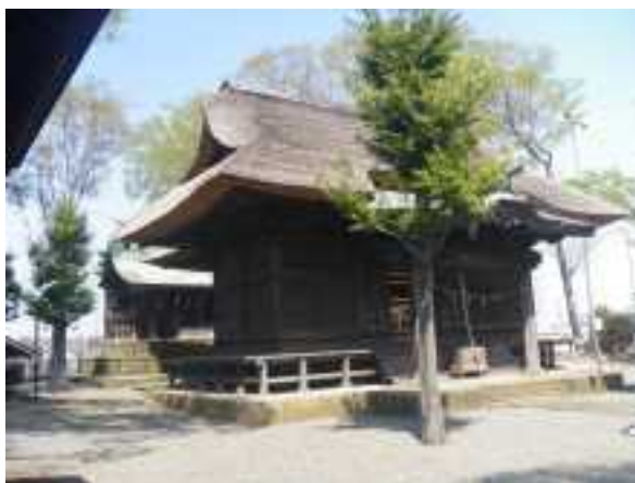
写真 66 高部屋神社拝殿・幣殿、本殿 (平成 28 年 2 月 25 日登録) [所有者] 高部屋神社 [時期] 拝殿・幣殿：慶応元年 (1865) 本殿：正保 4 年 (1647、江戸時代) 建立 昭和 4 年 (1929) 再建
