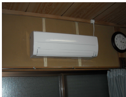
空調機は1台撤去、2台新設
