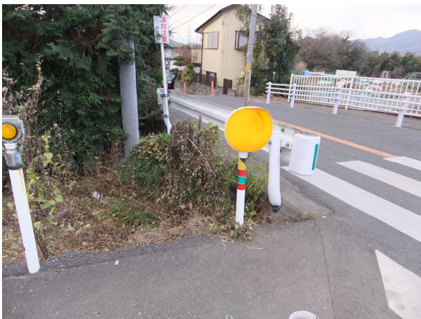
工事前の鋭角曲がり角
