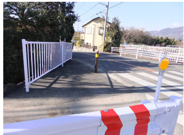
角切り工事完了後
