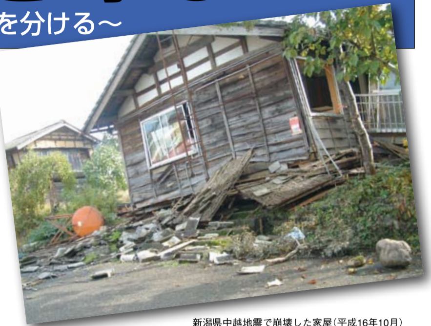
新潟県中越地震で崩壊した家屋(平成16年10月)
