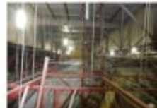
長過ぎる吊材。現場溶接の多用等。耐震性に問題のある特定天井内部
