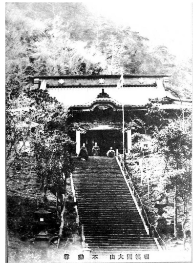
写真 28 再建された大山寺本堂
