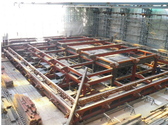
写真 124 宝城坊本堂平成の大修理
