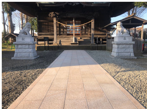
写真 133 高部屋神社参道の改修
