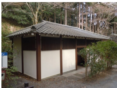
写真 135 改修した公衆トイレ
