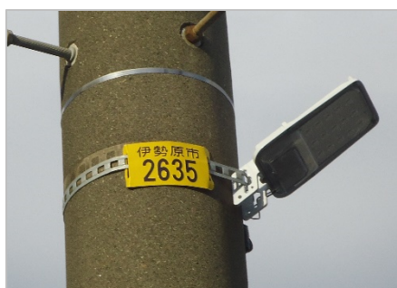
①灯具取付けバンドに通す方法
