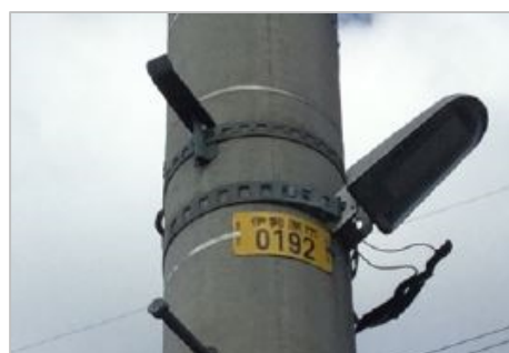
②プレートのみ取付ける方法
