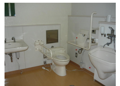
トイレの改修(みんなのトイレ)
