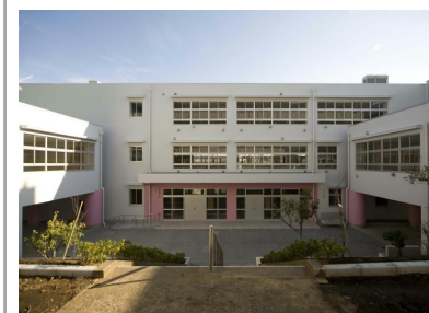
改築した桜台小学校2期校舎
