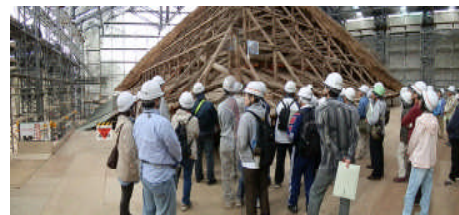
宝城坊本堂修理現場見学会
