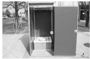
災害用マンホールトイレ
