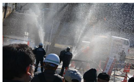
上水道復旧訓練
