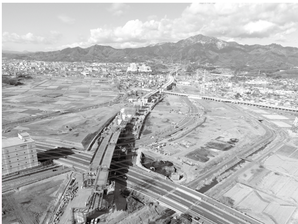
提供：中日本高速道路(株) (平成30年2月撮影)
