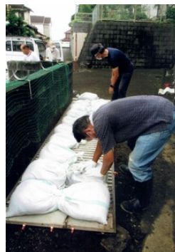
土のう積み込み
