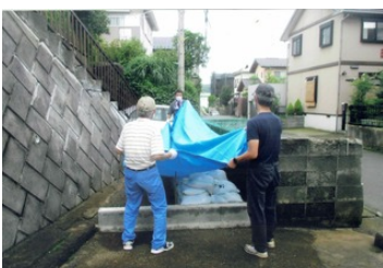
ブルーシート張り
