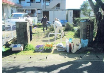
客土・植栽作業
