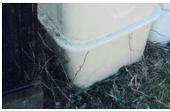
0.8トン貯水タンク
