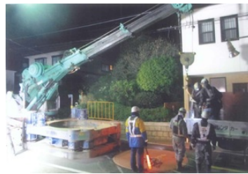
中間立坑工事1
