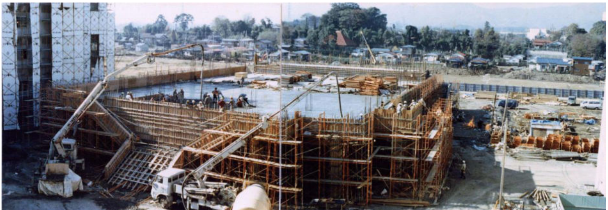
上は県立伊志田高校(開校昭和 51 年)の建設風景
