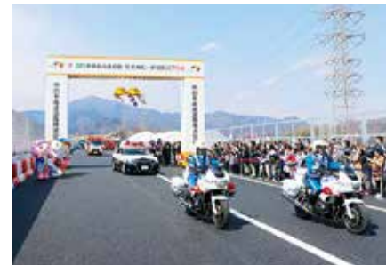
平成31年3月に開通した新東名伊勢原ジャンクション
