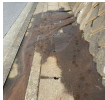
現場の土砂流出の状況
