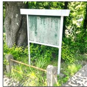
掲示板表面の劣化あり
