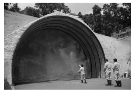
本格的な掘削工事が始まる前、平成29(2017)年6月の高取山トンネル
