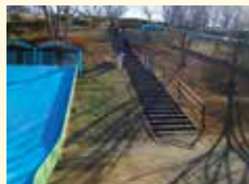
滑り台横の階段に沿って整備された手すり
