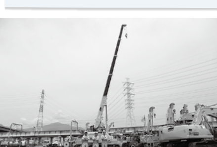
鉄骨や資材をつり上げるクローラークレーン
