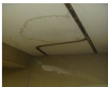
成瀬公民館 内部仕上 複数の雨漏り、内壁の塗装の 剥れ、床ビニールシートの劣化。
