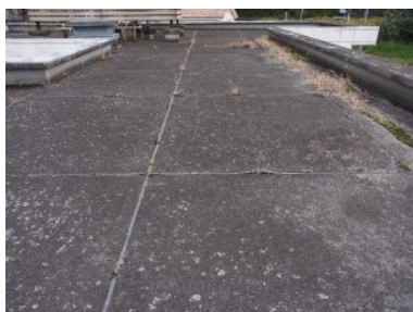
伊勢原南公民館 屋上 保護コンクリートの劣化。 広範囲の目地の暴れ。
