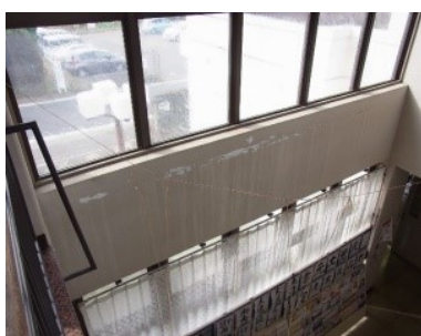
伊勢原南公民館 内部仕上 吹抜け上部内壁にひび割れ、 漏水痕がみられる。
