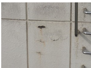
伊勢原南公民館 外壁 塗装の退色、ひび割れが進行し、錆汁がみられる。
