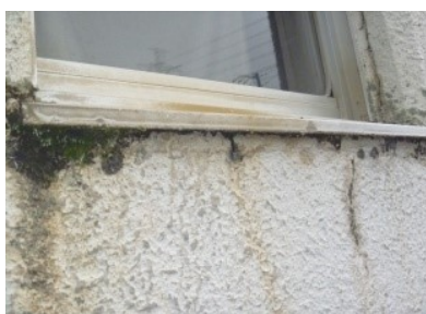
成瀬公民館 外部開口部 窓サッシ周囲のシーリングが硬化。 雨漏りの原因の一つと考えられる。
