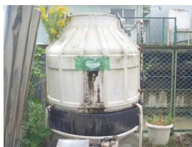
成瀬公民館 冷暖房換気設備 経年により、冷却塔(クーリングタ ワー)の劣化が進行している。
