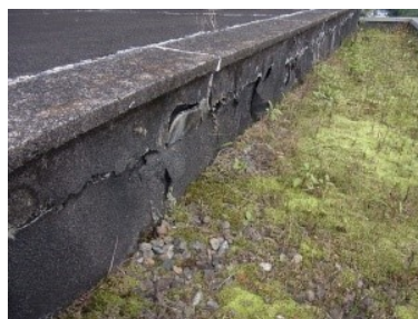
比々多公民館 屋上 立ち上がり部がひび割れ 剥落。雨漏りがある。
