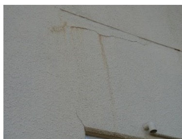
比々多公民館 外壁 チョーキング、ひび割れ、 錆汁がみられる。
