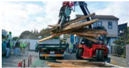
道路障害物除去訓練
