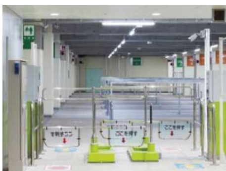
写真 7-29 自動ゲートシステムの例
