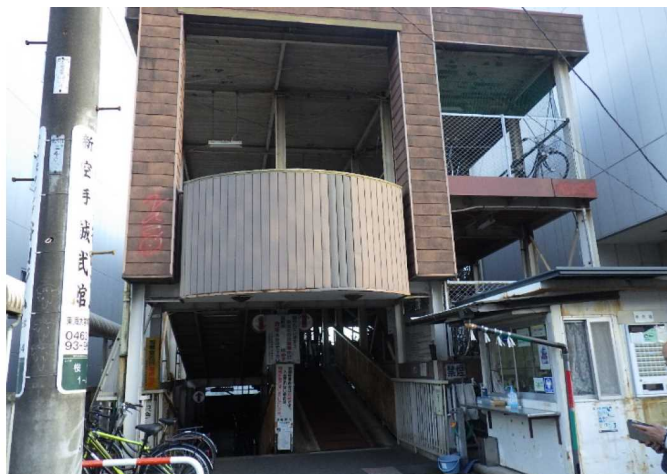
写真 7-2 伊勢原駅南口自転車駐車場
