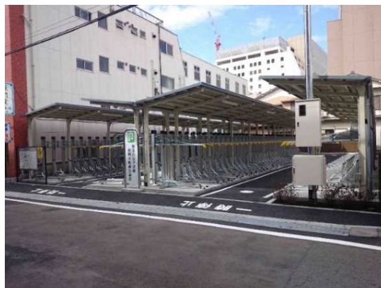
写真 7-26 屋根(シェルター)の設置例
