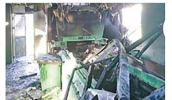
発火事故が起きた処理施設
