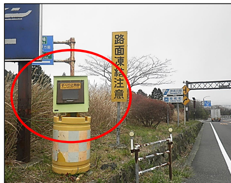
国道1号箱根峠(神奈川県箱根町)
