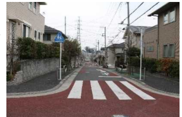
〈道路カラー舗装〉
