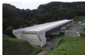
〈国道 246 号バイパス鈴川橋〉
