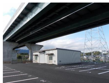
〈高架下の中央備蓄倉庫〉
