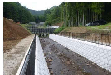
〈高橋沢砂防工事〉
