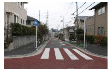
〈道路カラー舗装〉
