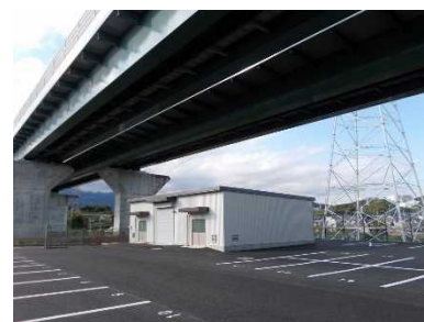
〈高架下の中央備蓄倉庫〉
