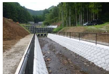
〈高橋沢砂防工事〉
