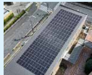
こどもみらいプラザに太陽光発電を設置し、再生可能エネルギーを活用しています
