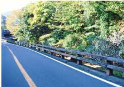
木に見える素材の柵で緑に溶け込む景観に(阿夫利橋付近)
