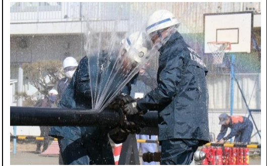
上水道復旧訓練
