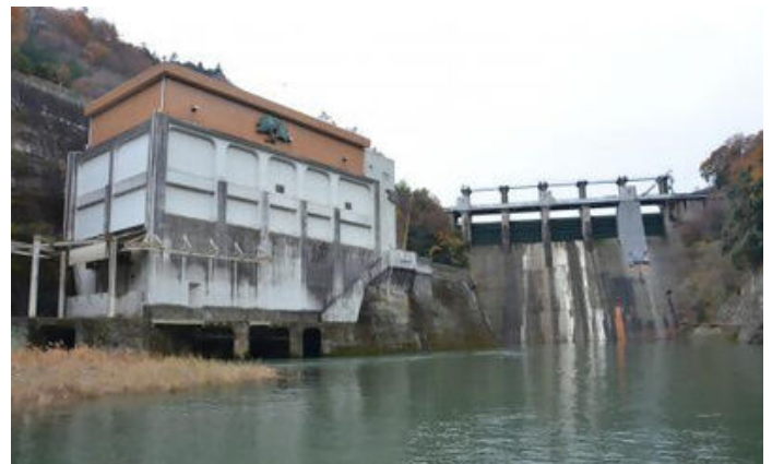
相模発電所の水力発電
