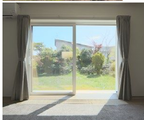
外窓交換(はつり工法)を実施
