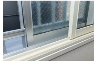
全住戸の内窓設置を実施
